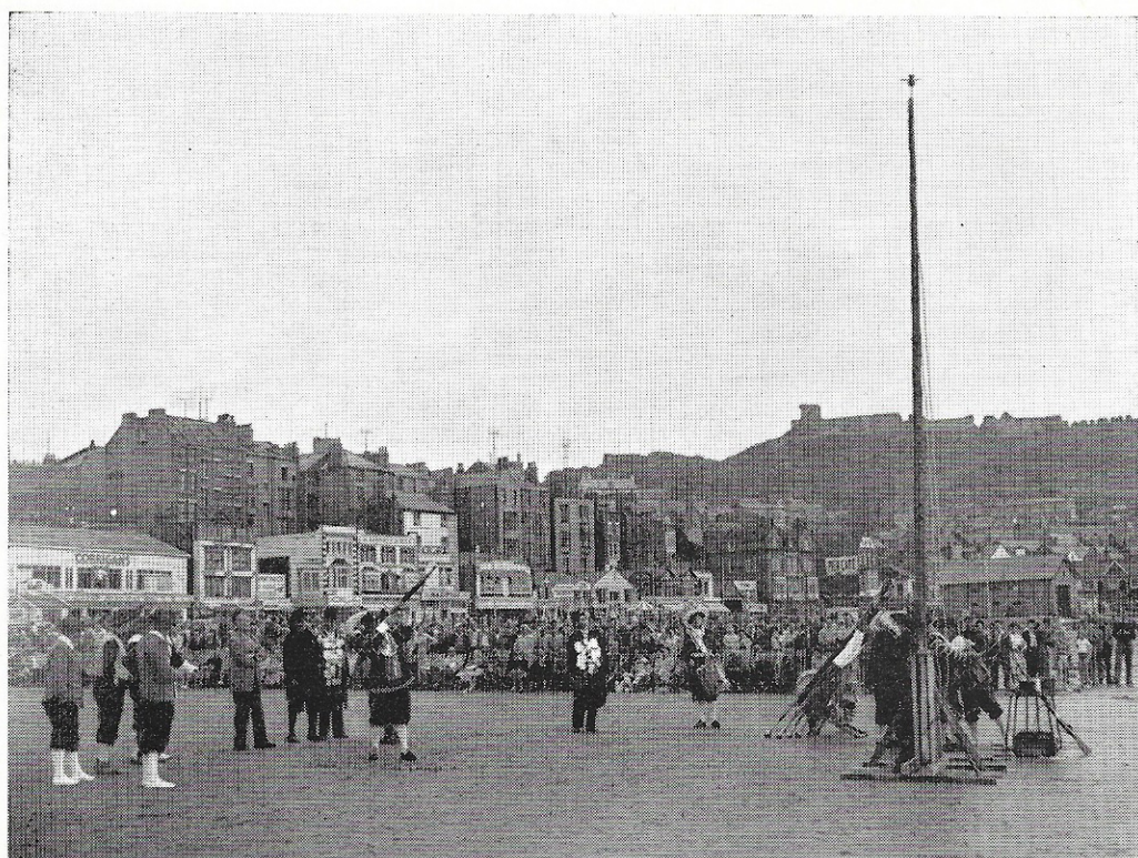
Koningsschieten op het strand te Scarborough. Alph. Niessen, voorzitter van de Kring Peelland, schiet zich voor één dag koning in Engeland.
