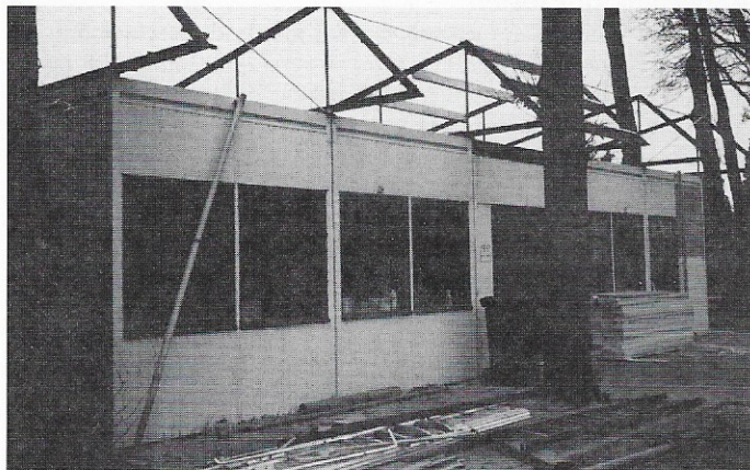
Op het geheel is een schuine kapconstructie aangebracht
