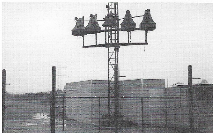
Als basis voor de schietmast is een zgn. dwarsligger van een bouwkraan gebruikt
