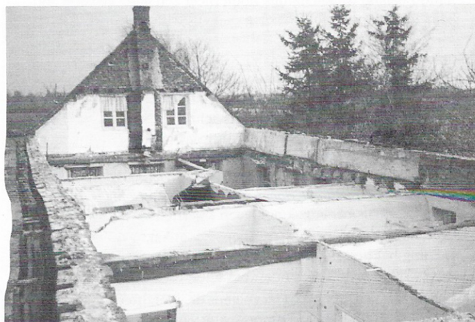
Vandalisme in Blitterswijk?
