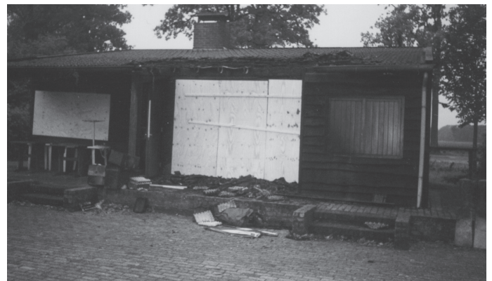
Het schuttersgebouw biedt een droeve aanblik na de brand
