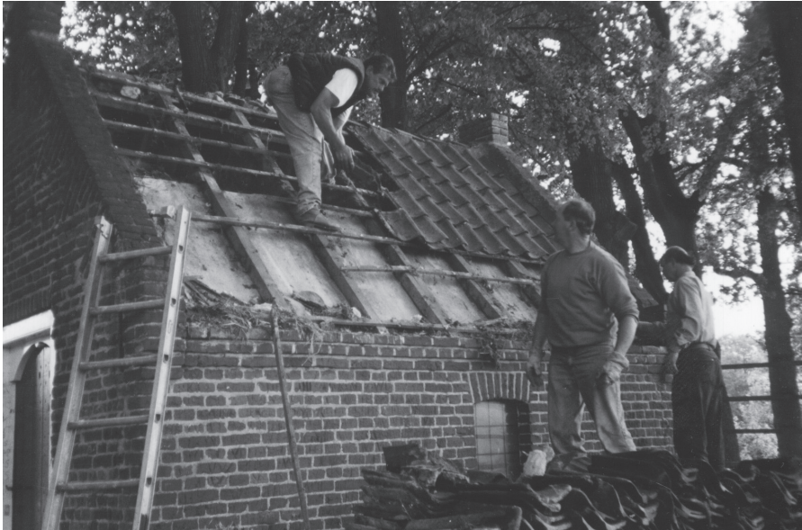
Gildebreders van Sint Jan zijn hier in 1999 bezig het dak van de kapel te vernieuwen
