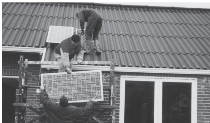
Plaatsing van de panels
