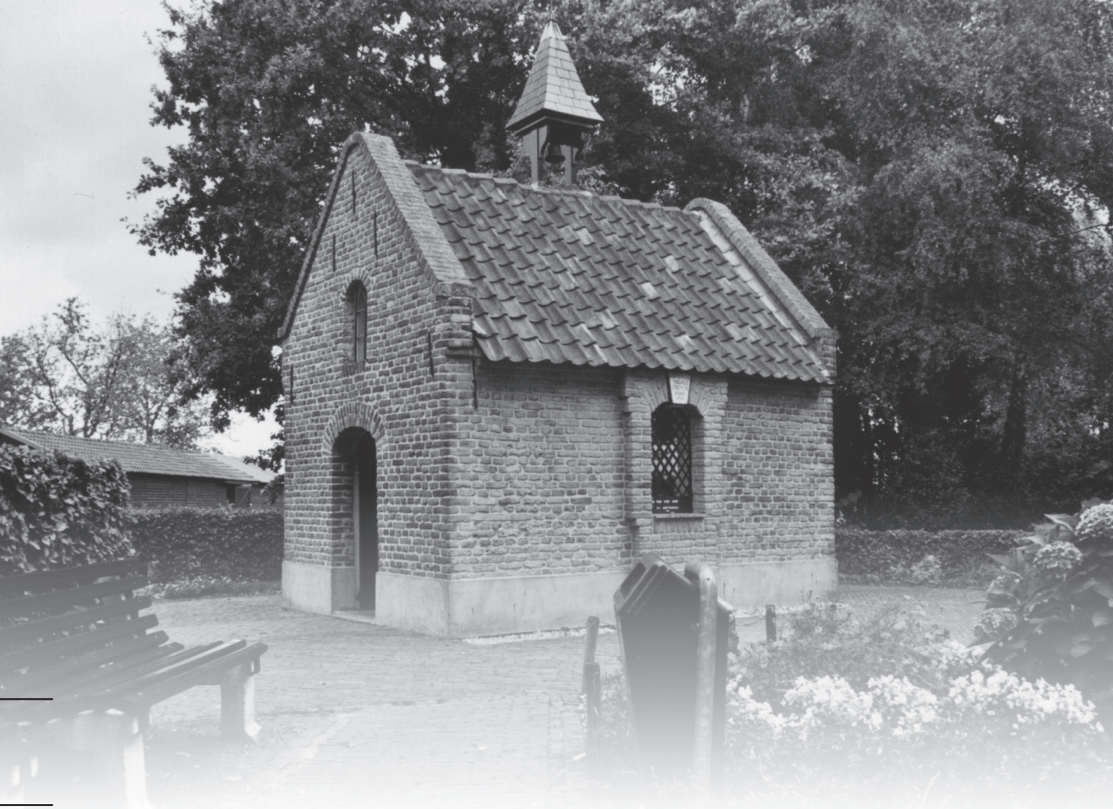
De gerestaureerde kapel anno 1999. De huidige vorm dateert van de laatste restauratie in 1990. De stuclaag is van de buitenmuren verwijderd. De boerderij en de boerenschuur zijn sinds begin zeventiger jaren verdwenen en door de reconstructie van de straatweg kreeg het kapelletje een groter erf rondom wat aan de eigenheid van de kapel ten goede komt. (foto Peter Lathouwers)
