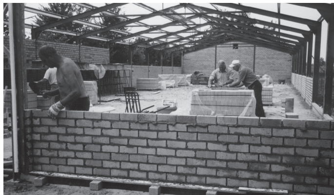
Gildehuis in aanbouw
