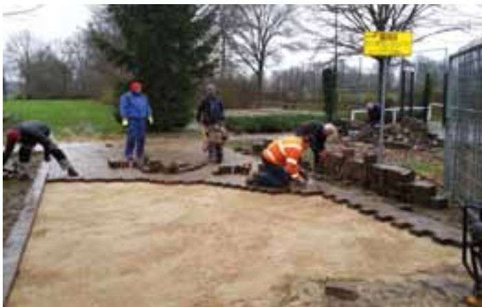
De toerit in aanleg.
