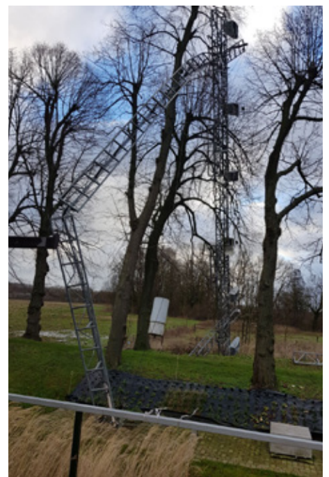
De verwoeste schietinstallatie.
